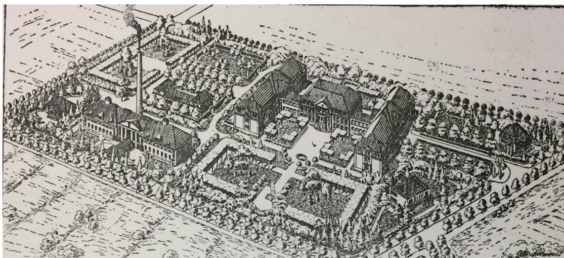
Abb. 8: Das neue städtische Krankenhaus in Cottbus (Vereinigte Städtische und Thiem'sche Heilanstalten) nach Fertigstellung 1914.
