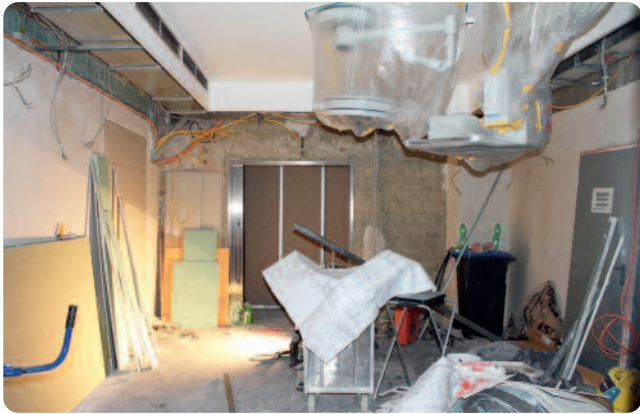
Während im neuen OP-Saal der Notaufnahme noch gebaut wurde, lief der Betrieb in etlichen Behandlungs- und Funktionsräumen schon auf Hochtouren.
